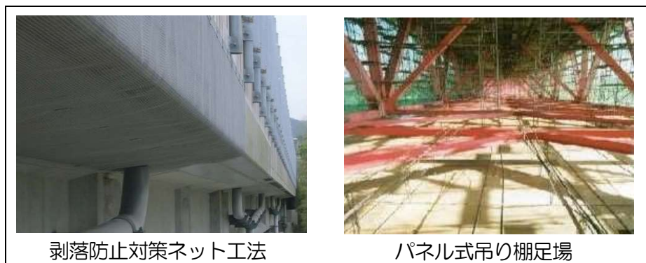
修繕等で効果が期待される新工法および新材料の例
