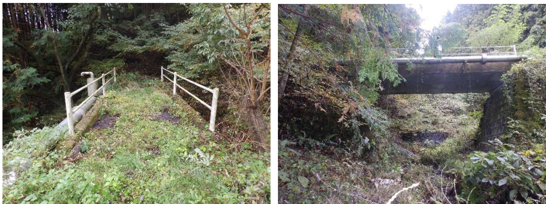
単純撤去候補となった橋の例
