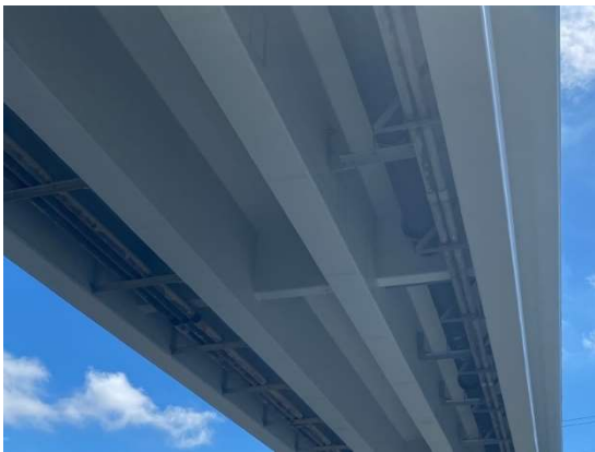
橋の下面状況（施工後）
