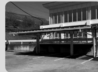
敷島保健福祉センター (ソーラーカーポート)
