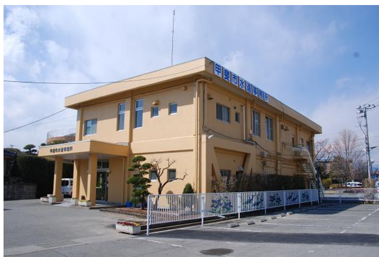
図 3.5 甲斐市水道事務所
