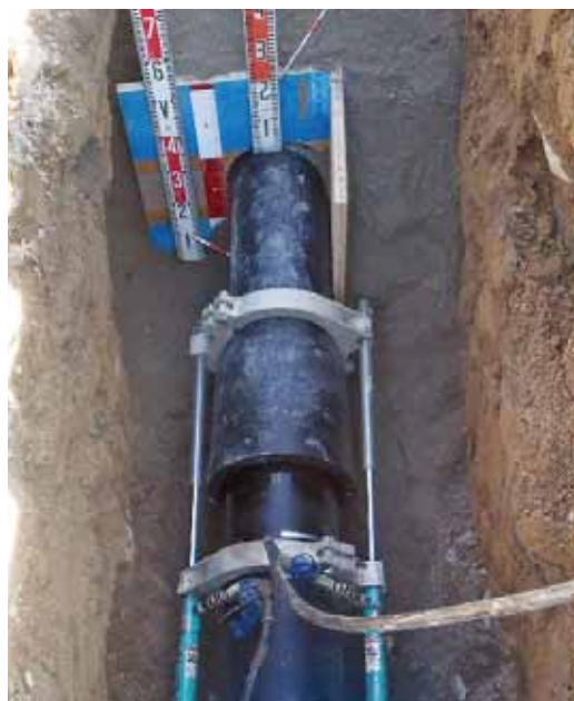
耐震性継ぎ手のダクタイル管の布設状況
