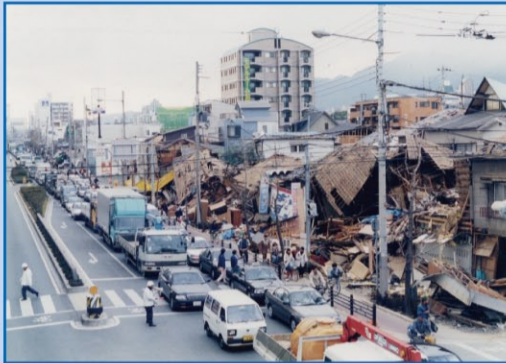
木造建物被害例 (平成7年 阪神・淡路大震災)
