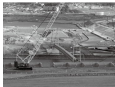
「希望の架け橋」撤去後の様子(H28.1)
