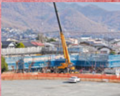
4月に開庁予定の敷島庁舎
