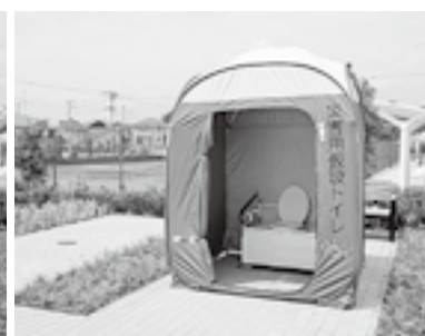
災害時に使用するマンホールトイレ
