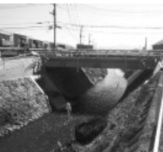
勸進橋災害復旧工事 1億9,446万円
