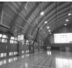
小学校屋内運動場 空調設備設置工事 4億1,030万円
