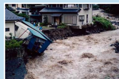
平成 12 年 9 月 亀沢地内 (家屋倒壊)
