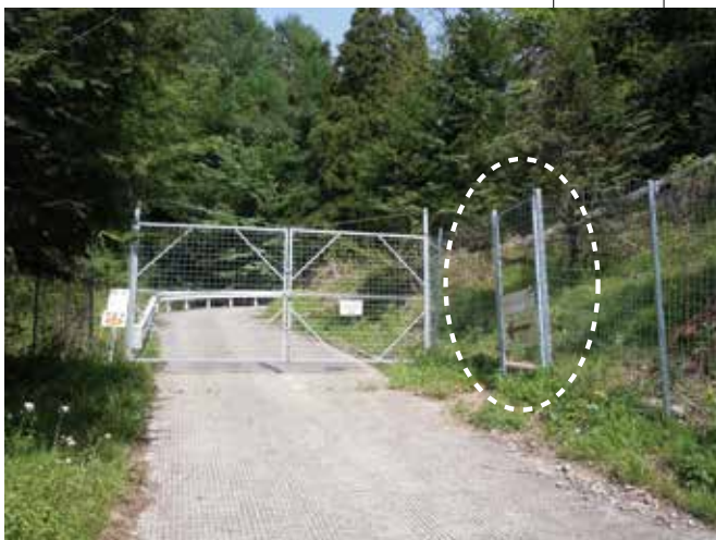
①入口となる防護フェンス(右側の小さい門から)
