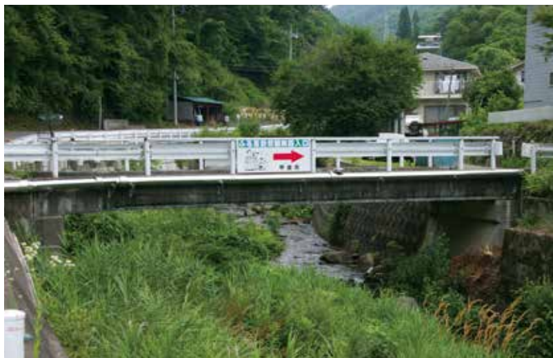
入口の橋(獅子平橋)
