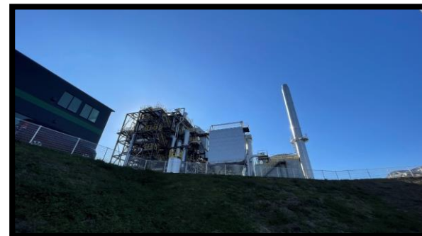
【ボイラー】外観
