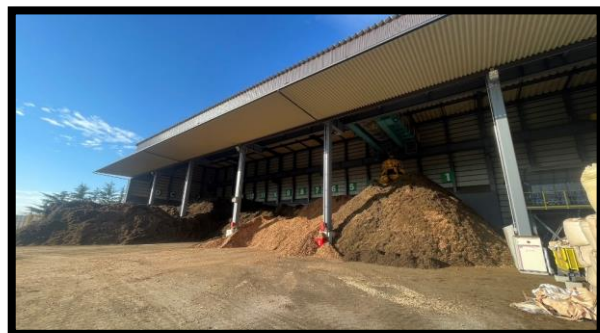
【チップ倉庫棟】外観
