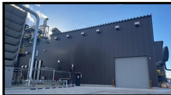
【タービン棟】外観
