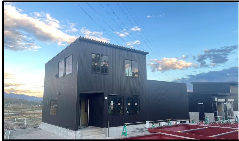
【管理棟】内装工事中
