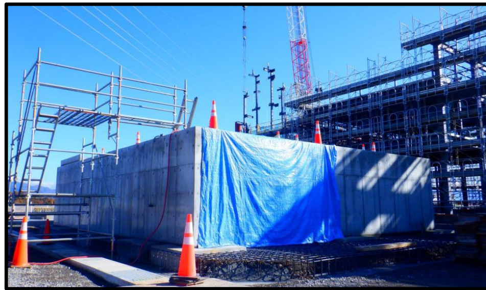
【冷却塔】水槽部完成
