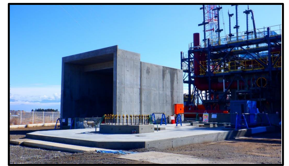
【灰ピット】完成
