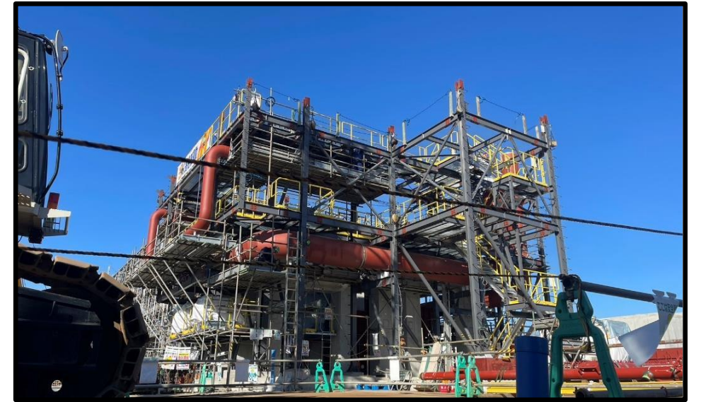
【ボイラー】主要構造物建設中
