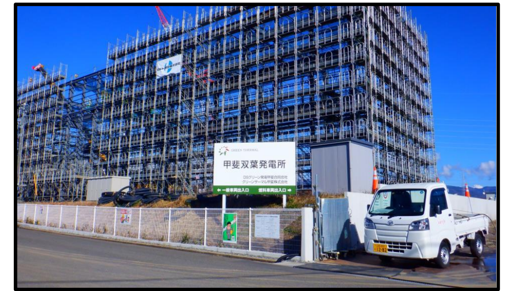
【南側出入口看板】完成
