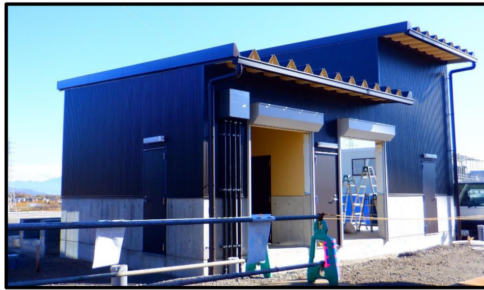
【倉庫兼ポンプ室】内装工事中
