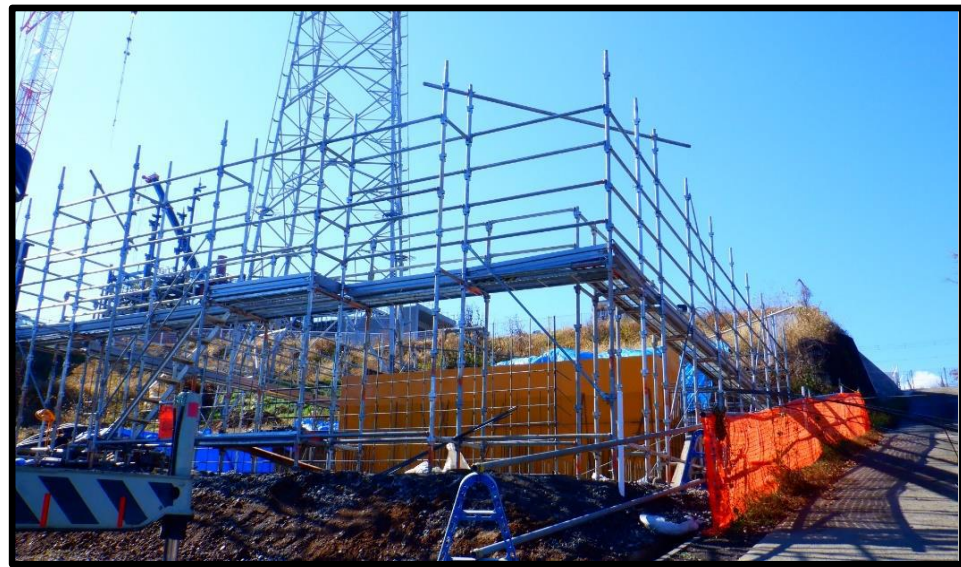
【特高受変電設備】基礎工事着手
