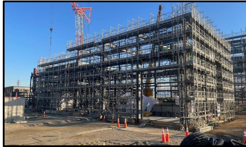
【タービン棟】主要機器据付中
