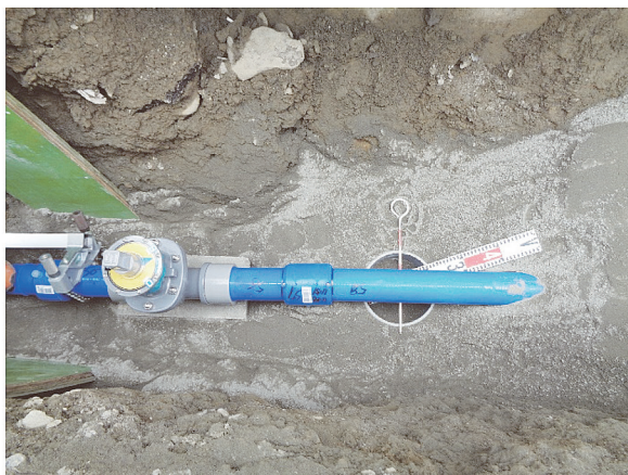
配水管布設替工事の様子
