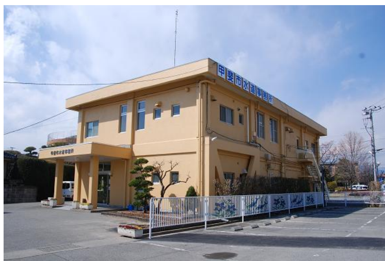
図 3.5 甲斐市水道事務所
