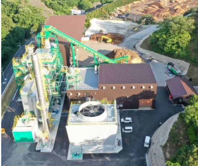
参考) 木質バイオマス発電所 ※DS グリーン発電和歌山合同会社
