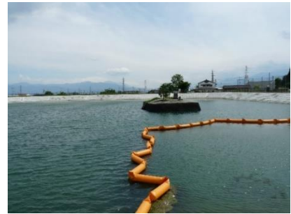
龍地大溜井（池）
