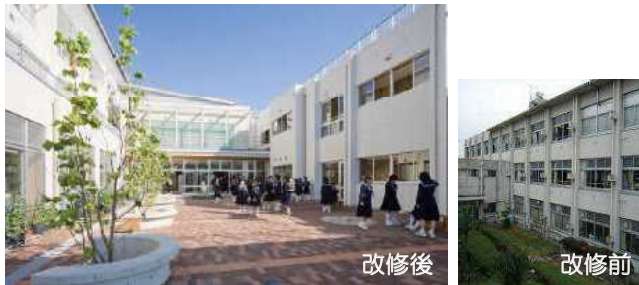
環境に配慮した学校施設として再生
