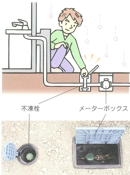
ルブを右いっぱい回し、蛇口を開けてください。水が抜けた後は蛇口を閉めてください。水抜きした蛇口を使用する際は、不凍栓バルブを左いっぱい回してから使用してください。（不凍栓バルブは、開・閉とも止まるまで回さないと漏水する恐れがあります。）
