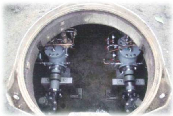
写真 5-3 緊急遮断弁
