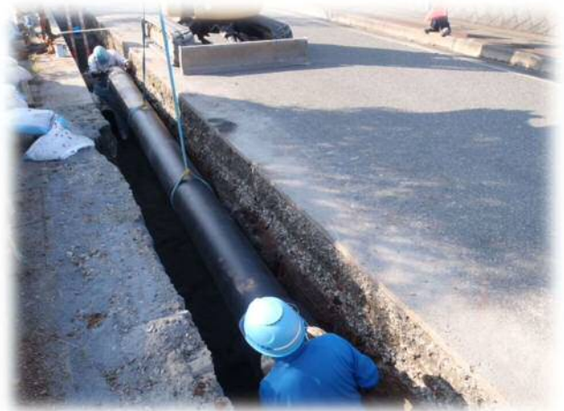
写真 5-2 耐震管の布設状況
