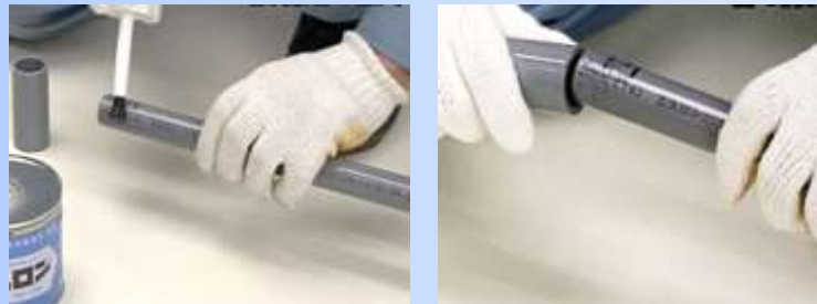
TS継手の接着
