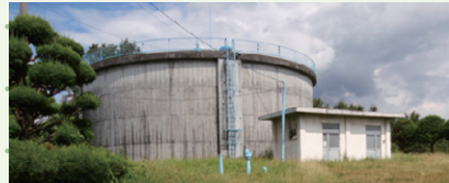
配水池 補修前
