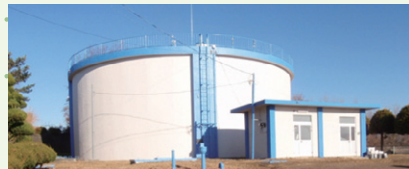
配水池 補修後
