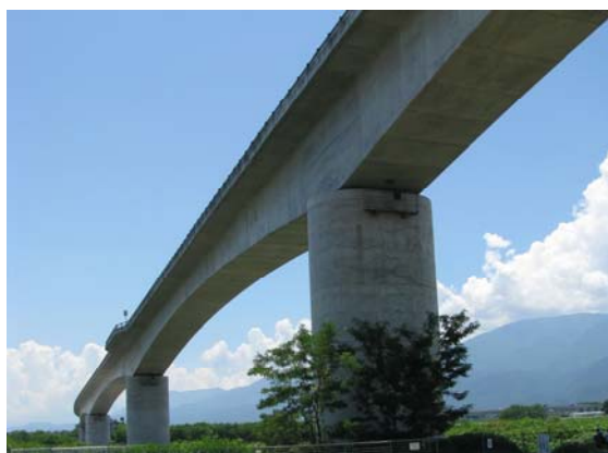
中部横断自動車道の高架橋
