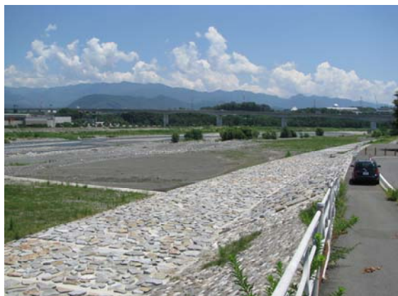
釜無川の石張り護岸
