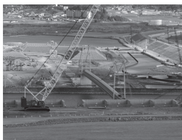
「希望の架け橋」撤去後の様子 (H28.1)
