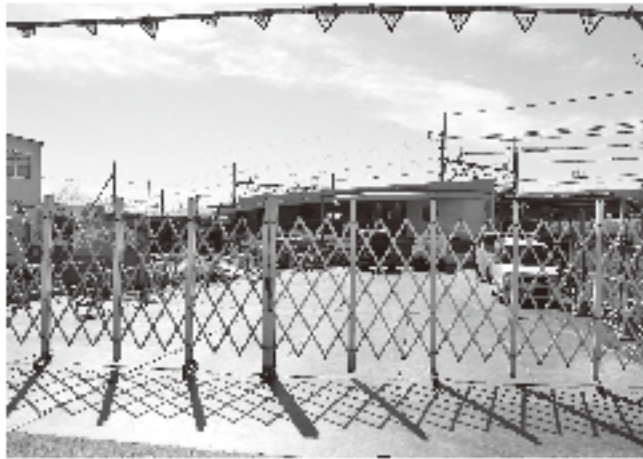
塩崎駅周辺整備事業(北口駅前広場側)
