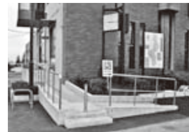
庁舎東側に設置したスロープ
