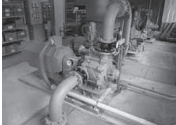
水道局では、配水ポンプなど老朽化した施設を計画的に整備・更新するとともに、主要な配水管の耐震化などを進めています。
