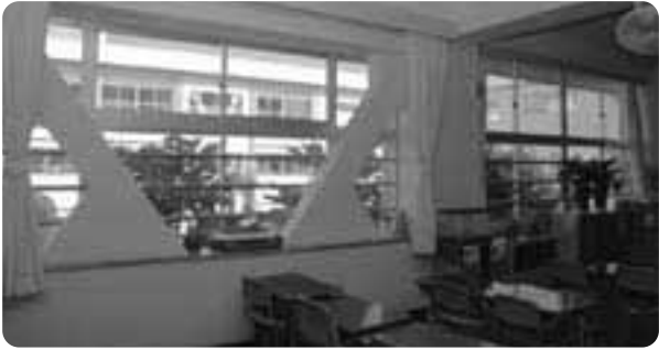
小中学校耐震補強工事
