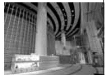
電力館エントランス
