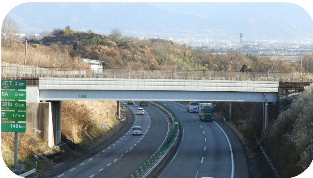
大境橋：甲斐市宇津谷 昭和54年竣工 橋長33m (令和3年度 計画に基づく補修工事実施済)
