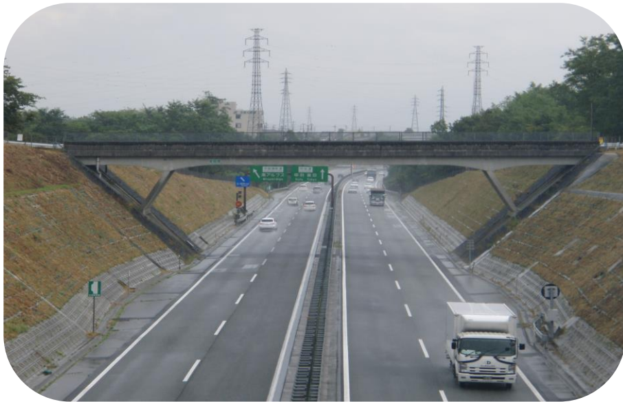
(東堀橋：甲斐市岩森 昭和54年竣工 橋長44m)
