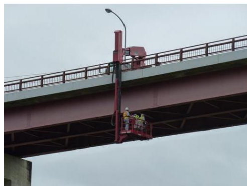
点検車による点検実施状況（宇津谷橋）
