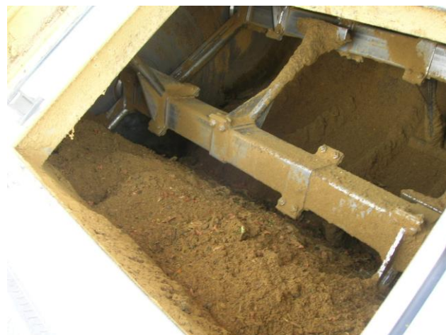
装置内部の様子
