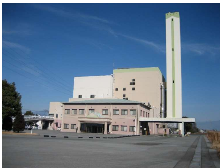
中巨摩地区広域事務組合（清掃センター）
