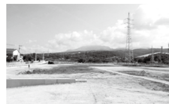
バイオマス産業都市推進事業 (発電所用地造成工事等) 1億1,130万円
