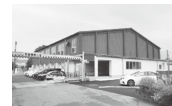
竜王南小学校屋内運動場改修工事 3億7,534万円
